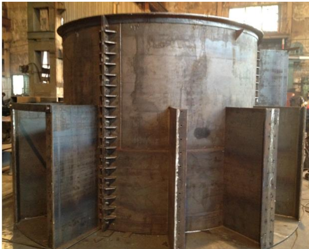
Изготовление металлоконструкций пульподелителя
