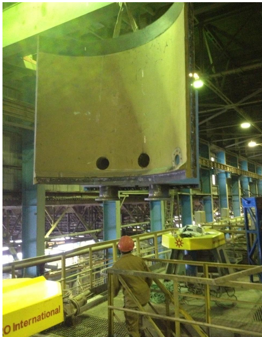
Сборка пульподелителя на месте установки заняла не более 6-ти часов
